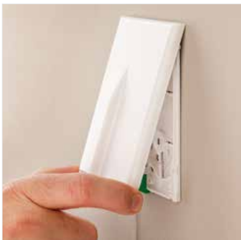
Aufsetzen der Gehäuseabdeckung
