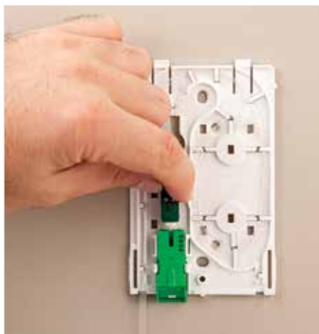
Anschluss einer 900-µm-Glasfaserfestader im Wandmontagegehäuse
