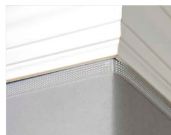
Um eine Ecke im Außenbereich installierter Clear Track Quad-Glasfaserkanal
